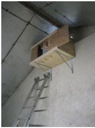
Nestkast direct achter het gat in de gevel.
