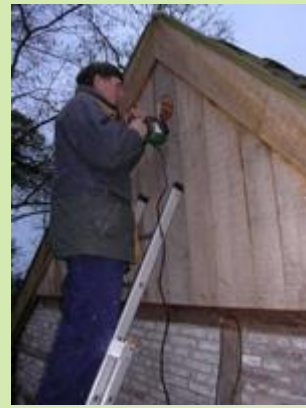
Gat in nok om uil toegang te verschaffen.
